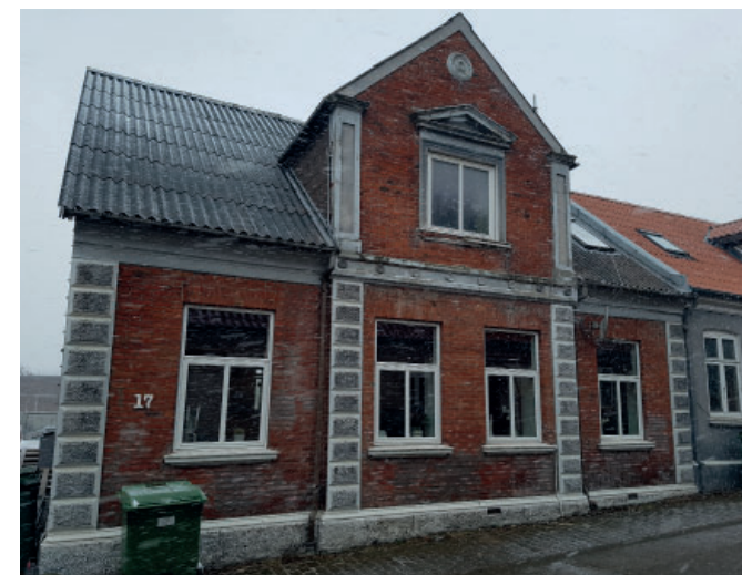
Frederiksgade 17 i Lemvig - før renovering
