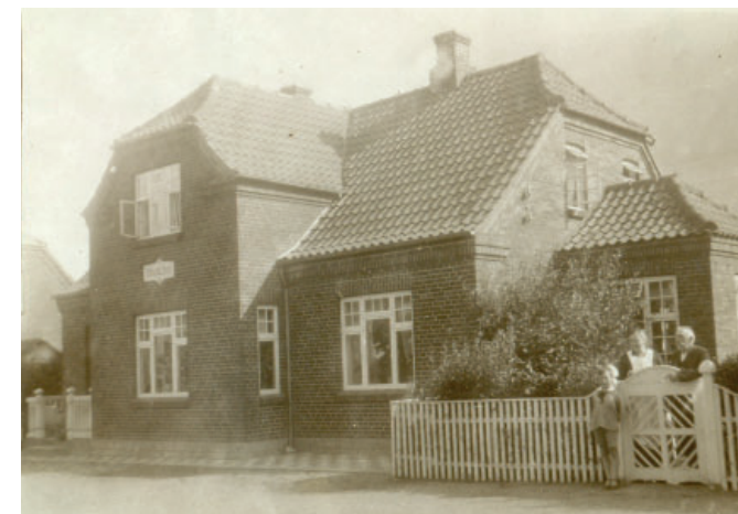
Wümpelmann's hus, Thyborønvej 24, Klinkby er opført i 1915 og overtaget i 1924 af Jacob Johan Wümpelmann (herfra navnet). Huset hed oprindeligt 'Solblink', hvilket stod i spejlfeltet mellem de to vinduer på facaden. Huset fik middel bevaringsværdi (4) i bygningsregistreringen. Huset fremstår i dag velholdt, men er desværre blevet pudset siden registreringen i 1996. (foto udlånt fra Lemvig Museum)
